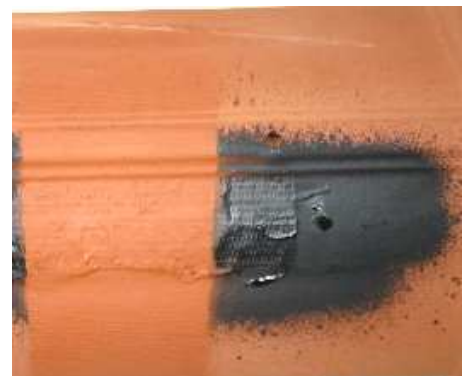
Adhérence sur tuile réparée au colmateur
